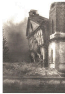
Demolición de la antigua Iglesia Parroquial de San Ramón. Colección Museo Regional de San Ramón, Universidad de Costa Rica.
