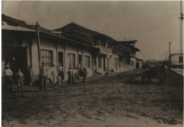
Calle en San Ramón, donde hoy se encuentra el edificio de la POPS, hacia 1920. Colección Museo Regional de San Ramón, Universidad de Costa Rica.
