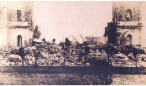
Iglesia Parroquial de San Ramón en proceso de demolición, San Ramón después de 1924. Colección Museo Regional de San Ramón, Universidad de Costa Rica.
