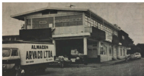
"La Municipalidad de San Ramón, un edificio funcional para las necesidades de los comunales. La antigua municipalidad fue cedida para la instalación del Centro Regional Universitario." Hacia 1975 Archivo Biblioteca Nacional de Costa Rica. La República. 28 de agosto de 1975.
